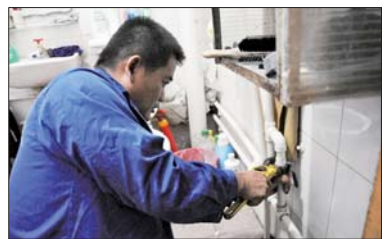
爱心师傅上门为社区居民修理太阳能管道。
