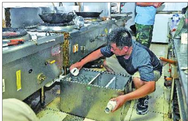
一家饭店厨房里,工人正安装油水分离机。(资料片)
