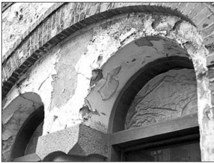
“红房子”外墙墙皮剥落。本报记者 张晓鹏 摄
