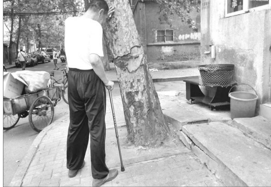
在树的底部,树根已经将水泥台阶掀起。本报记者 柳斌 摄
