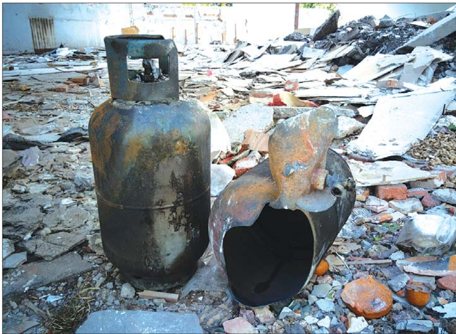
起火餐馆屋内的两个煤气罐,一个罐体爆裂。本报记者 张伟 摄
