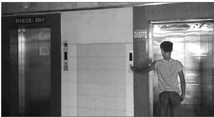
4日,事发的蓬莱中医院(老院区)住院部一楼电梯口处市民正在等电梯,事发的西侧电梯上贴着“电梯已封、禁止使用”。 本报记者 蒋大伟 摄
