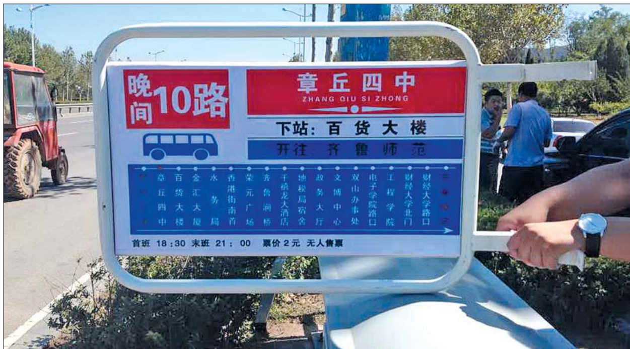
工作人员正在安装晚间公交站牌。
