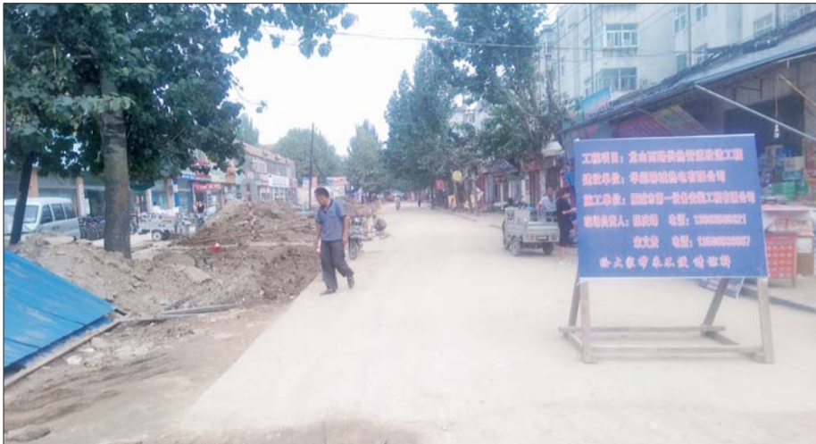
龙山西路正在进行供热管网改造。 本报记者 谢晓丽 摄
