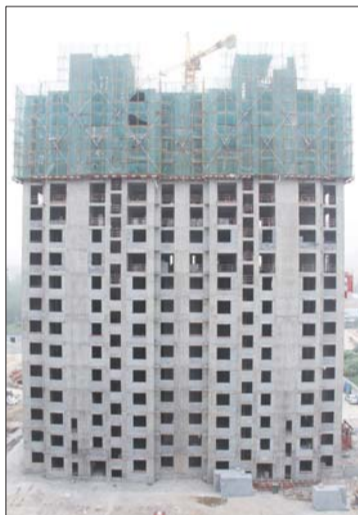
图为正在建设中的公租房项目。本报记者 谢晓丽 摄
