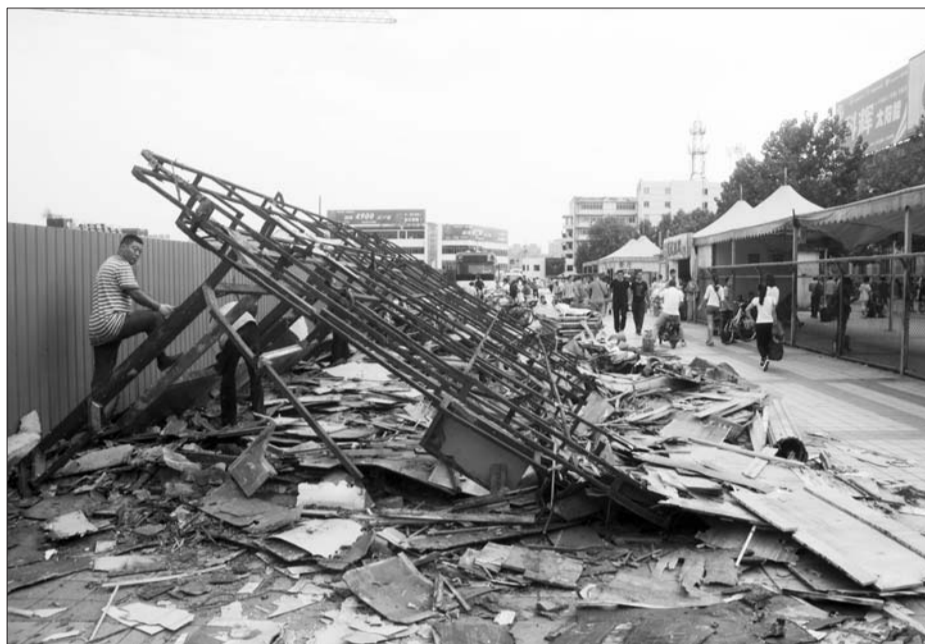
德州火车站广场上的售卖商店已开始拆除,为站房的搬迁改造做准备。本报记者 马志勇 摄
