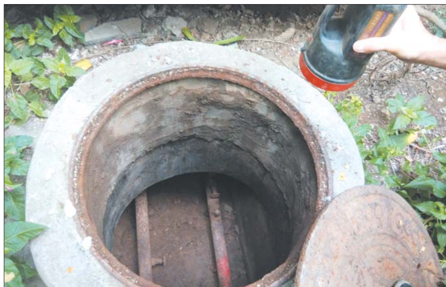
▲佛山苑内的供热管道陈旧,保温层基本都脱落了。
