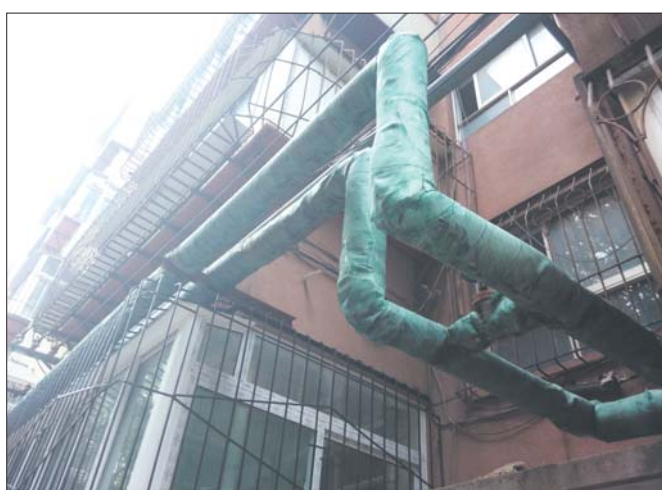
▲佛山苑内的供热管道陈旧,保温层基本都脱落了。
