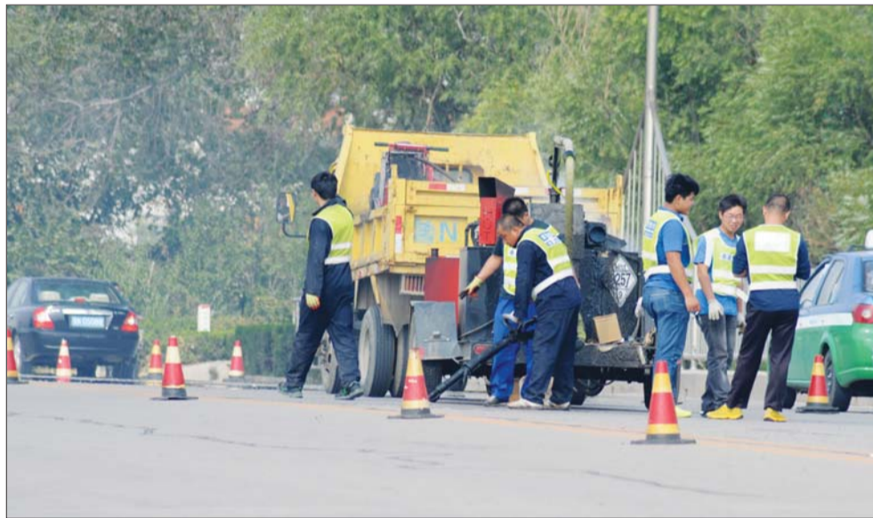
9月25日,市政工作人员在天衢路岔河桥上对路面裂缝问题进行修补。 本报记者 马志勇 摄
