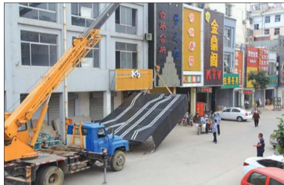
执法人员借助吊车拆除广告牌。 本报通讯员 侯飞 摄
