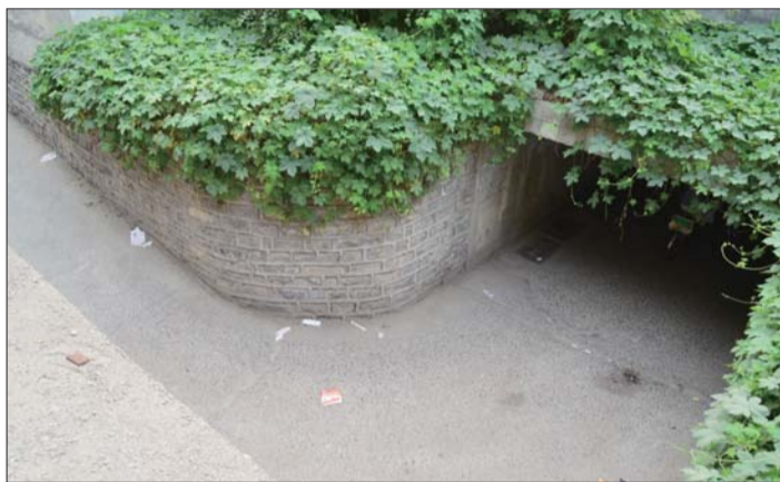
冲下陡坡,骑车女桥洞撞亡
