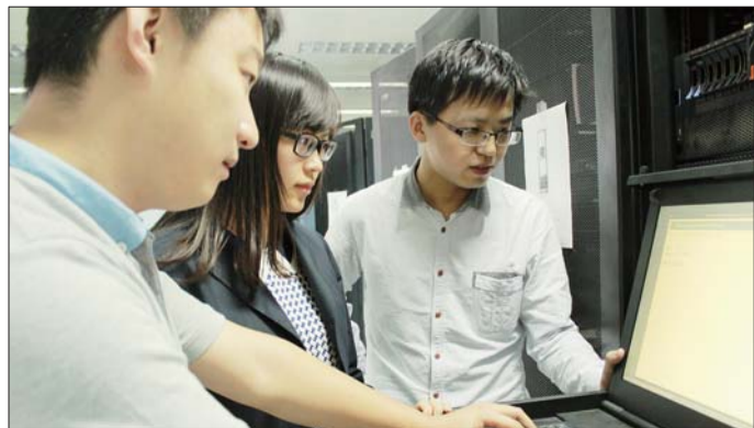
维护人员正在机房巡视。
