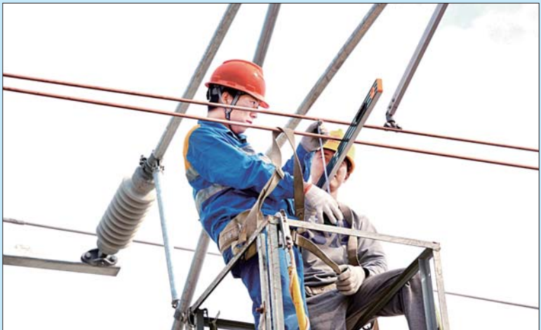
近日,青岛供电段对青荣城际铁路接触网设备开展立体式、全方位检查验收。图为该段职工在测量锚段关键线间距。 弭远波 王斌 摄影报道
