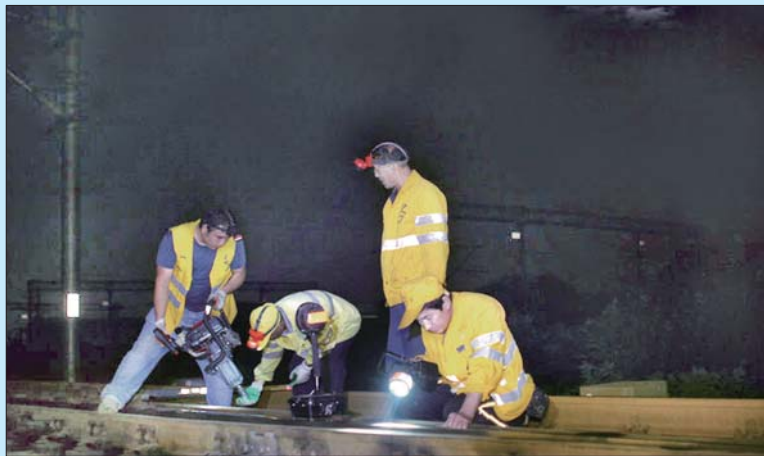
济南西工务段利用中秋小长假加强高铁设备检查,对晃车地点进行集中整治,对站区关键设备做好巡检。图为该段职工夜间整治白马山2号道岔。 崔俊杰 摄
