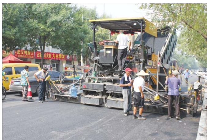
黄河四路改造现场
