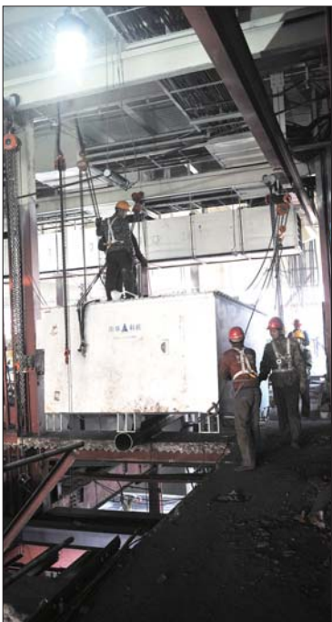
兖州煤业洗煤厂改造每年可增加效益7亿元。兴隆庄选煤厂技改现场。(资料片)
