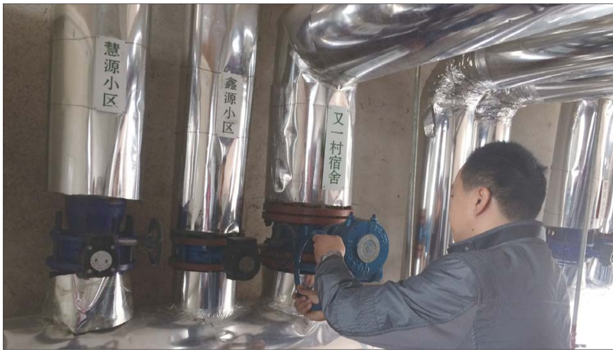
10月9日上午,在堤岭换热站,工作人员调试小区二级管网阀门并注水试压。贺莹莹 摄
