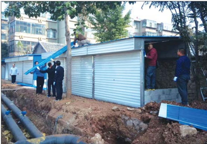
工作人员正在拆除违规铁皮屋。本报记者 张伟 摄
