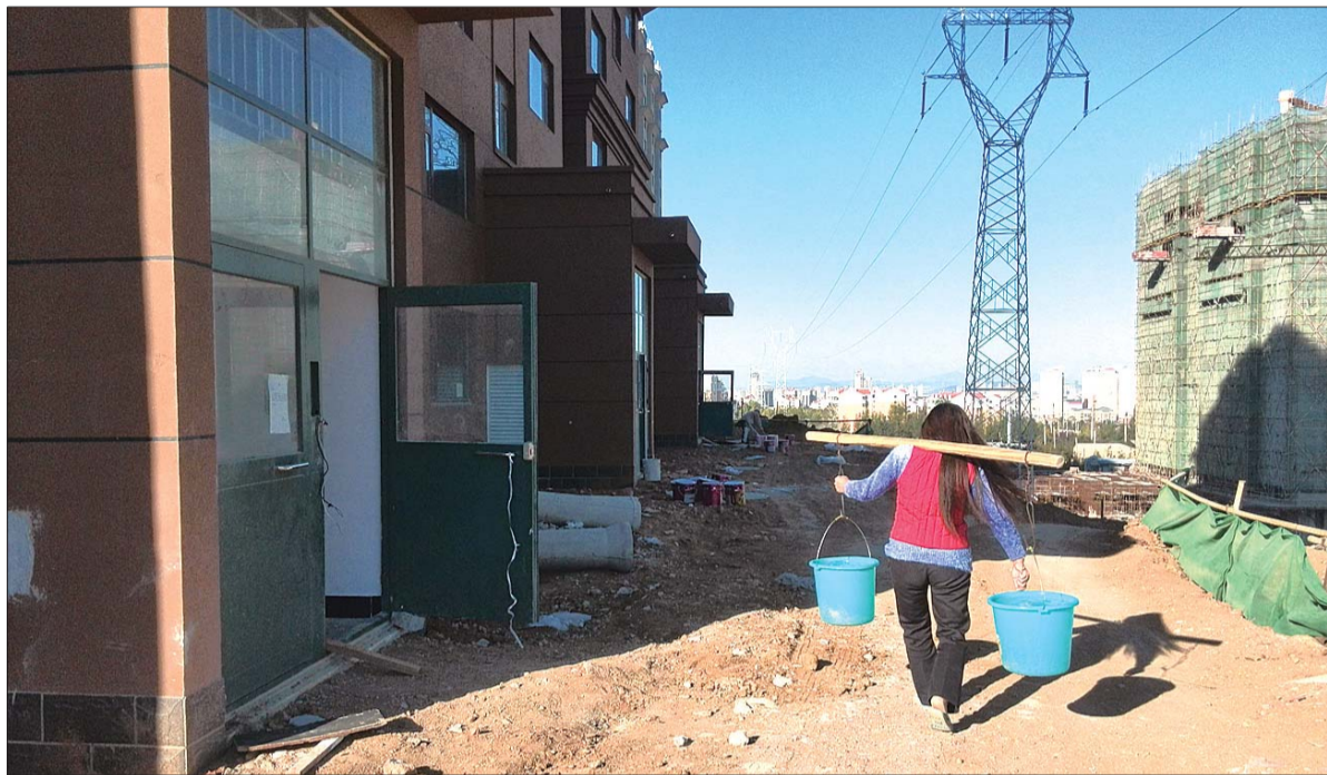
没有水电,工作人员挑水施工。 本报记者 柳斌 摄
