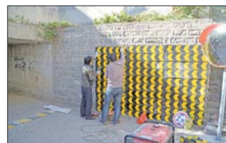
工人在安装警示标志。
