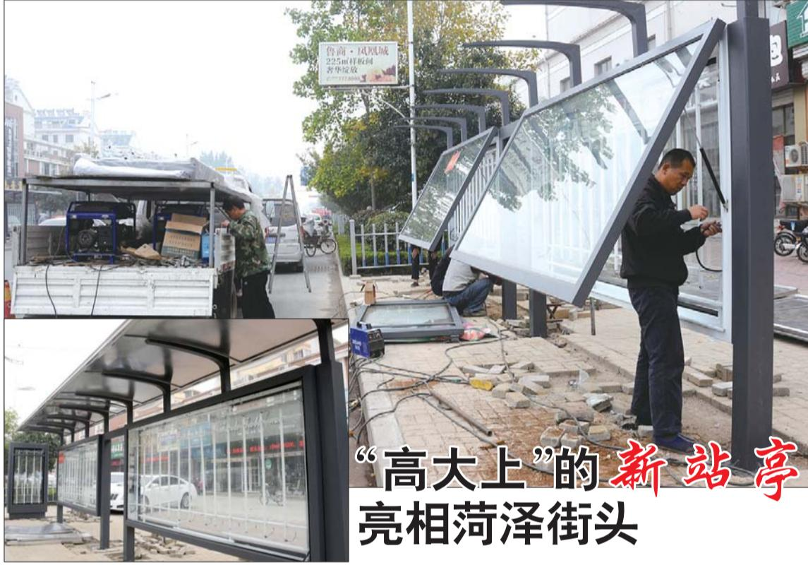
27日,记者在华英路上看到,施工人员正在安装新的公交候车亭。新式候车亭整体呈灰色,全部采用碳钢材料制作,比老式候车亭更加结实耐用。据公共汽车公司经理助理袁文东介绍,华英路正在安装新候车亭棚顶,当日已完成6个,预计30日完工。西安路也已完成地基工作,牡丹路正在做地基,长江路与黄河路正在拆除旧站牌,准备施工。两年内完成市区187处老式候车亭、站名牌更新改造工作。 本报记者 邓兴宇 摄影报道
