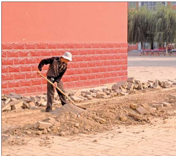
管道已经铺好,工作人员在回填土。
