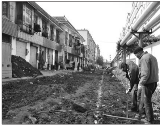
施工人员正在修整太平街。 本报记者 公素云 摄
