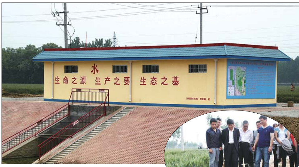
▲投入使用的小农水重点县建设泵站。(图片均由通讯员周伟伟提供)
