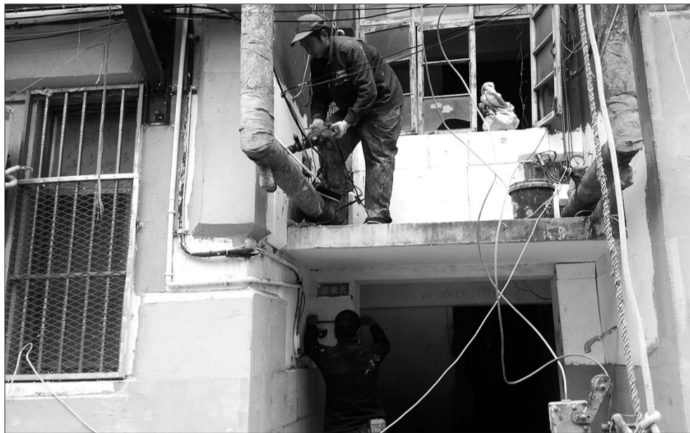
工作人员正在安装保温板。本报记者 公素云 摄
