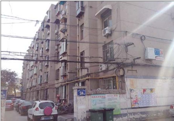
花园小区西区属于老旧小区,实现集中供暖比较困难。
