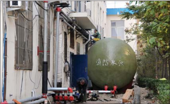
施工人员正在给水罐安装管道。 本报记者 王鸿哲 摄
