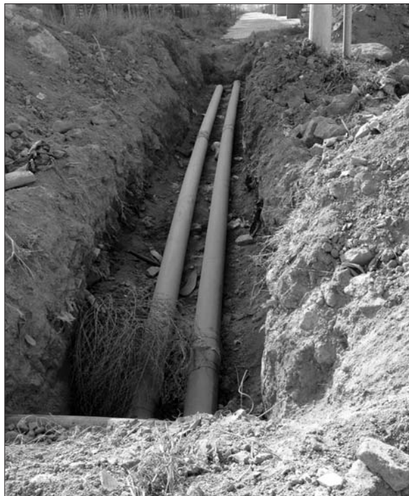
▶管道还差70米,暖气迟迟通不来。
