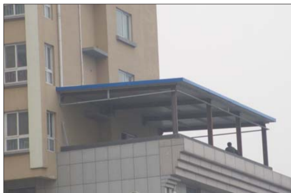
违章铁皮棚建于楼顶的公共平台,张店南定镇建委已经责令拆除。 本报记者 刘光斌 摄
