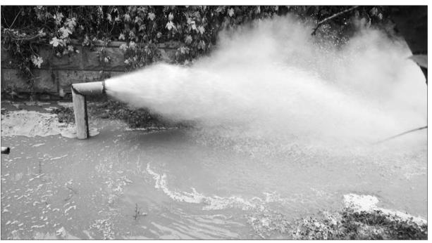
15日,供暖首日,在三八东路上一处供暖管道排气口处,涌出大量的热蒸汽,并发出巨大的呼啸声。 据相关工作人员称,此现象是排气设施损坏所导致 马志勇 孙婷婷
