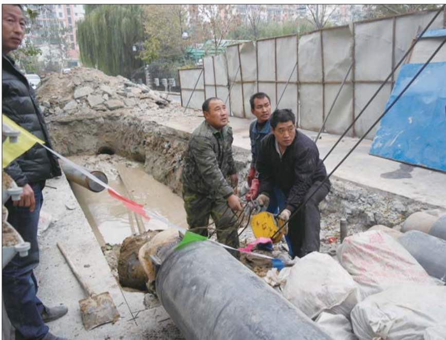
御景苑施工人员正将管道引入地下。 本报见习记者 杜雅楠 摄
