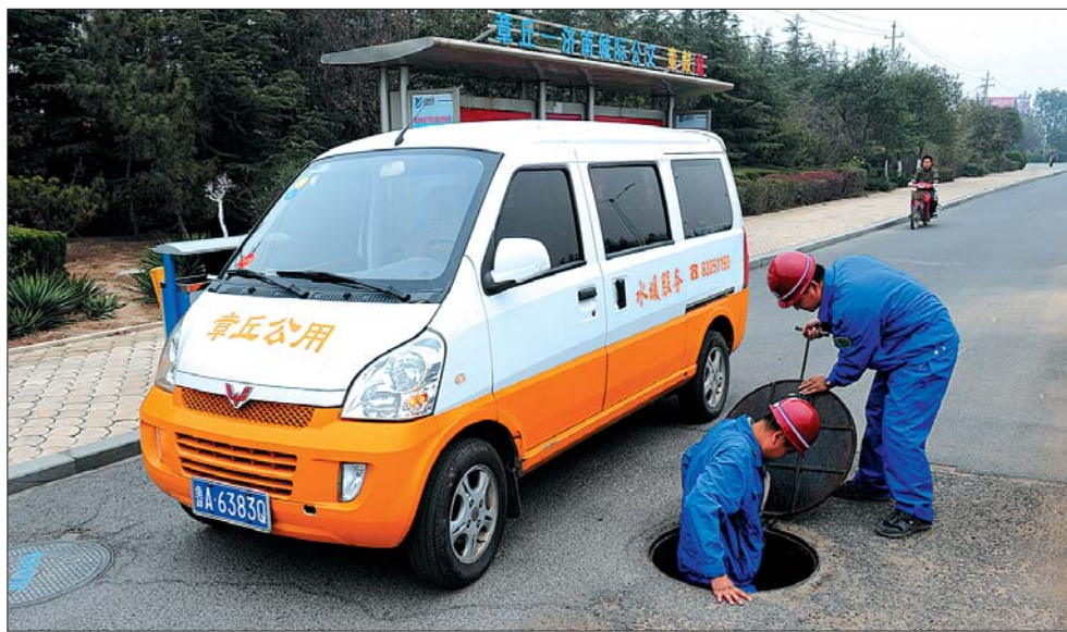
工作人员巡线检修管道。
