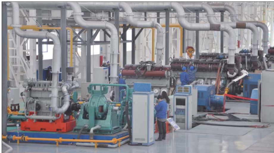
占地500亩、总投资20亿元的淄柴工业园车间一角
