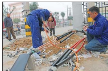
24日,和平路相关区域架空电力线缆落地改造正在进行。
