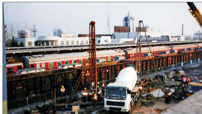
改造施工中的聊城火车站。(资料片)
