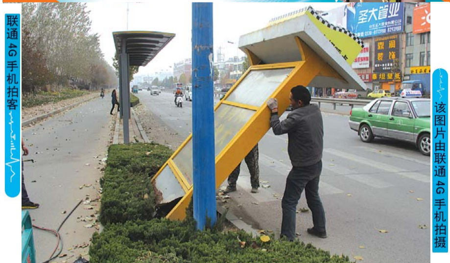
工作人员拆除违规设置的出租车招呼点。本报记者 张伟 摄
