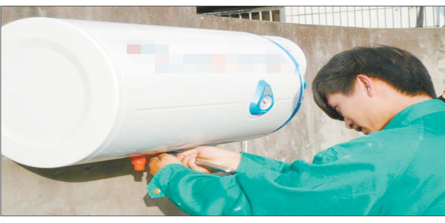
热水器安装应由专业人员操作。(资料片)
