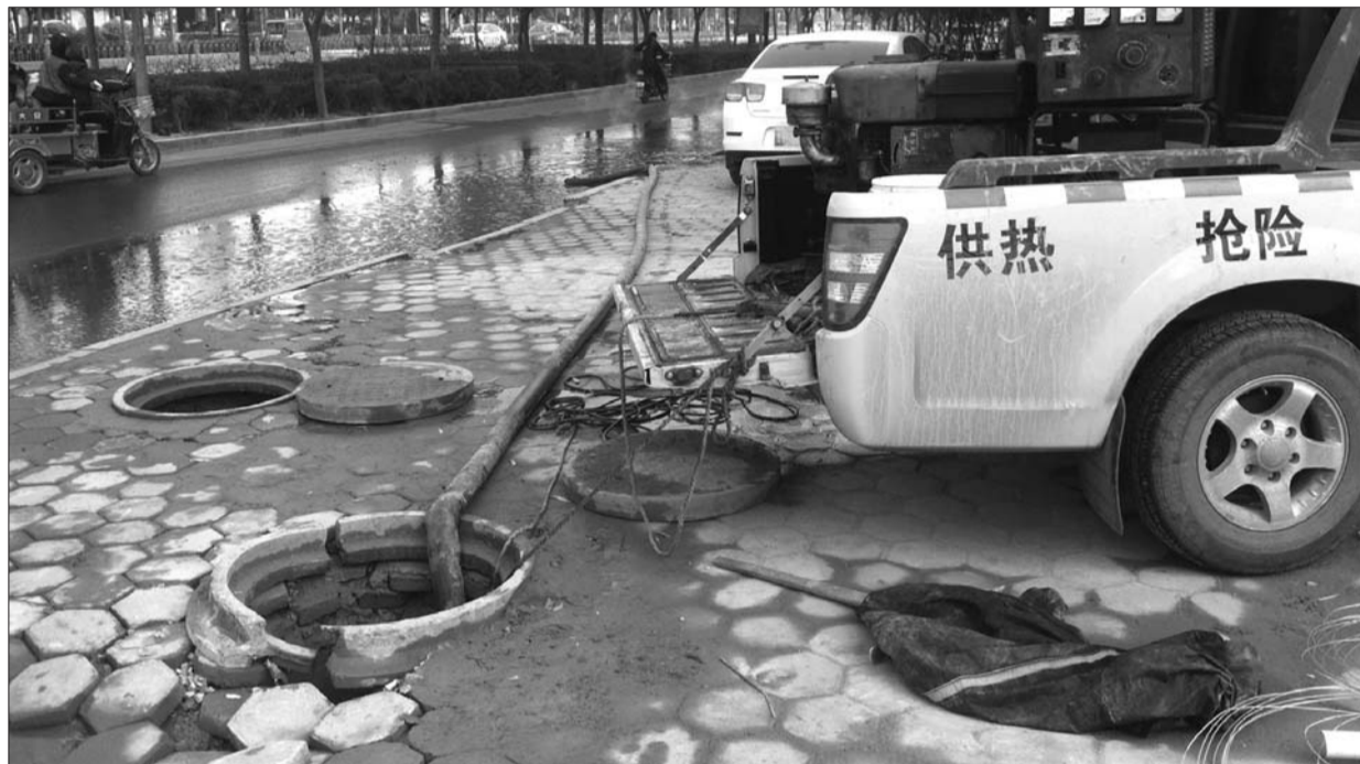
供热公司抢修人员正在抽排热力检查井内的水。 本报记者 张召旭 摄
