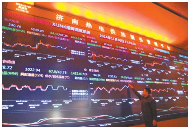
济南热电公司的智能化供热平台可实时监控供暖情况,调节热源。
