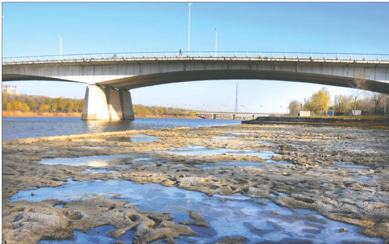
1日，全市最低气温达到-5.8℃，锦绣川景区内内的浅水结冰，也正因冷空气来临天空湛蓝。 本报记者 马志勇 摄
