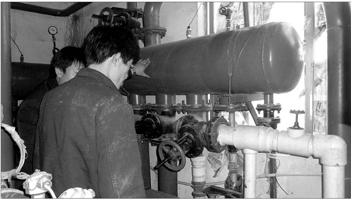
▶专家在亨通园小区检查供热情况。
