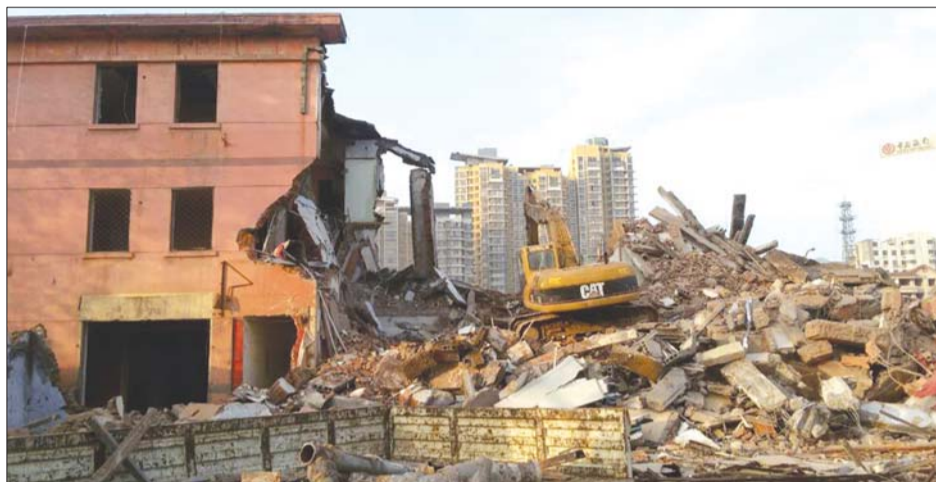
五湖宾馆开始拆除。 本报通讯员 齐文 摄
