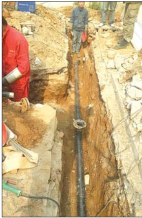
气象局铸铁管改造后。本报通讯员 摄
