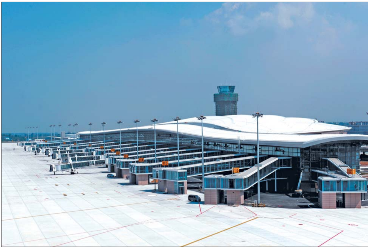
烟台蓬莱机场将成为我省除济南、青岛之外三大支线机场之一。
