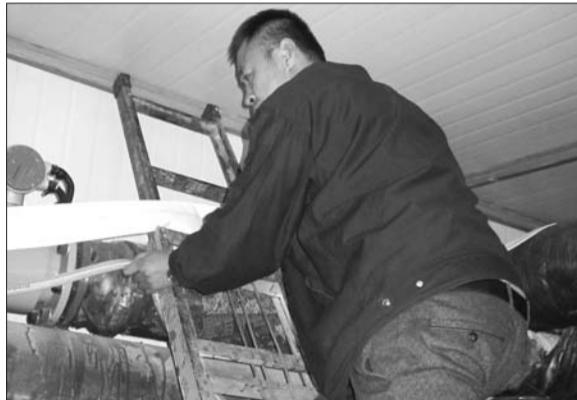
工作人员正在连夜架设供水管道。
