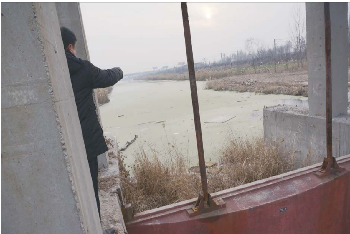
水闸关闭后,污水无法外排,形成了一条“死水沟”。李榕 摄
