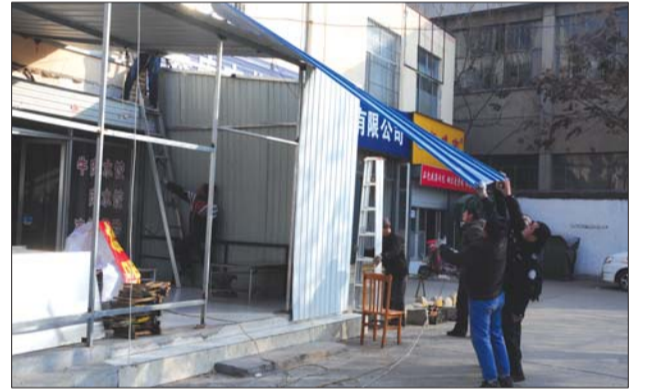
工作人员正在拆除铁皮屋。 本报记者 张伟 摄
