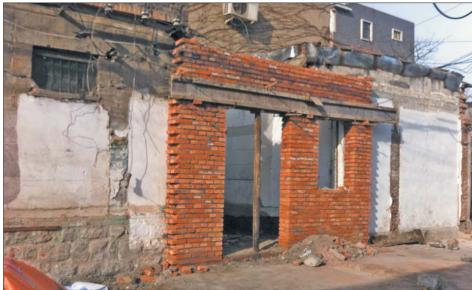
刚刚建起的门头房墙体。
